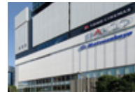
PARCO_ya上野 東京都台東区上野3-24-6 地下1階-6階 OPEN:2017.11.4 上野フロンティアタワー 地上7-10階
